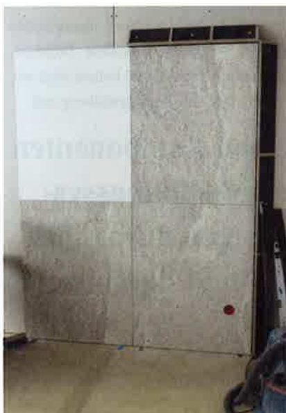
Saubere Sache: Bündige Montage auf Stoß; Materialkombinationen, auch unterschiedlicher Plattenstärke (hier beispielshalber mit lackiertem Holz), sind ebenfalls leicht realisierbar.
