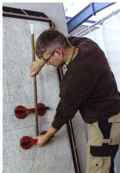
Mit wohldosierter Hebelkraft wird die magnetische Anziehungskraft überwunden, um einzelne Plattenelemente zerstörungsfrei und ohne Mühe wieder zu entfernen.
