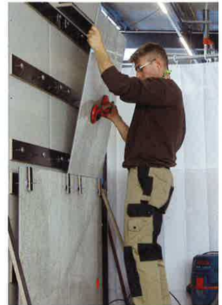
Leichtbau mit Naturstein: Für die schnelle Montage von BlendStone-Hybrid-Natursteinplatten mittels »ReVisionSys«-Magnethaltesystem braucht es eine Arbeitskraft und nur wenige unterstützende Hilfsmittel.
