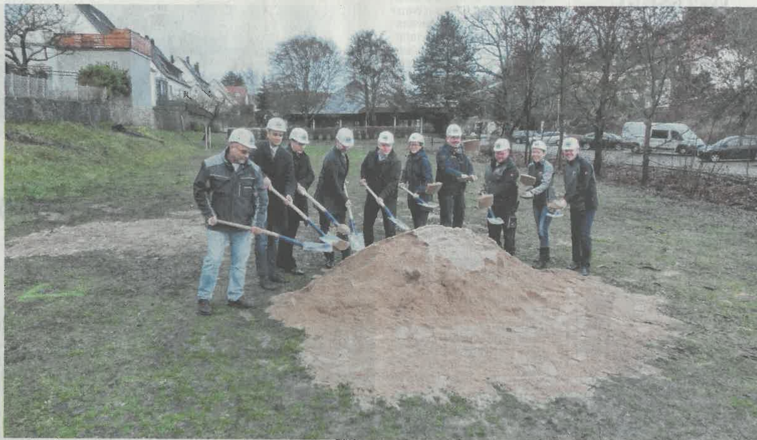
Spatenstich für das Wohnungsprojekt auf der Pfarrwiese im Unteren Weinberg im Reichenberg: (von links) Höhn-Bauleiter Elmar Oesterer-Kneitz, Baurat Matthias Noll (Regierung von Unterfranken), Pater Mario Muschik, Alexander Krebs (Diözese), Architekt Martin Nörpel, Bauunternehmerin Paula Höhn, Bürgermeister Stefan Hemmerich, Bona-Projektleiter Thomas Ehrenfels, Tanja Diebel (Bona) und Bona-Geschäftsführer Matthias Brand. FOTO: R. MENSCHICK
